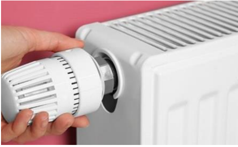
Рис. 3. Встановлення терморегулятора опалювального приладу
