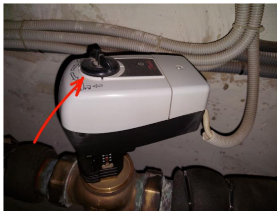
Рис. 2. Пристрої (кнопка) для ручного управління положенням запірно-регулювального органа регулятора теплоти на сервоприводах різної конструкції
