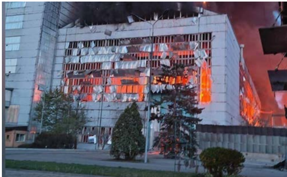
Зруйнована Трипільська ТЕС
