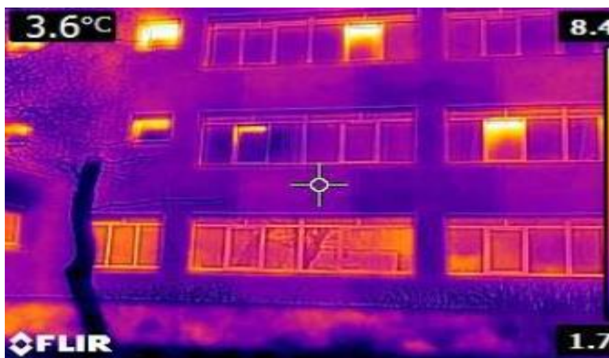
Рис. 4. Термограма будівлі школи з мінімальними тепловтратами
